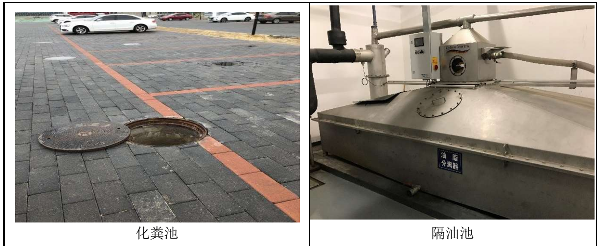
图 5.2-2 本项目废水处理设施
